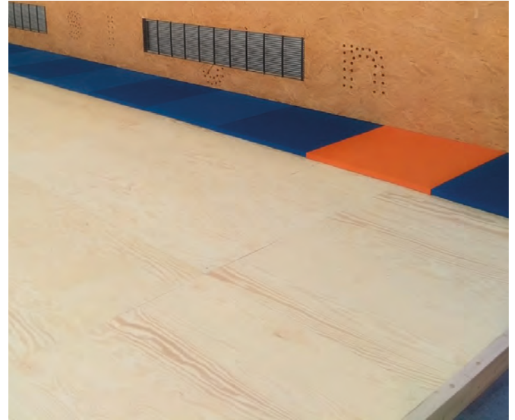
Unterkonstruktion mit Tatamis
